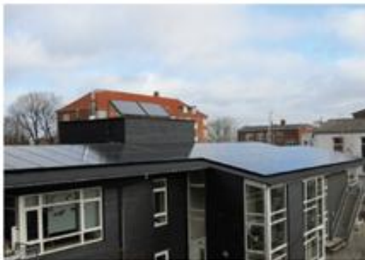
Lanternen Anlægsstørrelse: 24 kWp Installationsår: 2011
