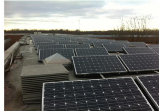
Høje-Tåstrup Rådhus Anlægsstørrelse: 126 kWp Installationsår: 2011
