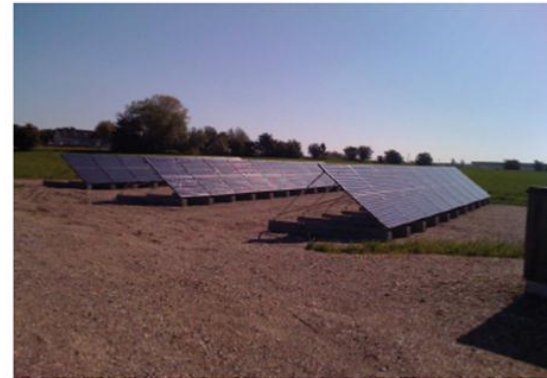
KE Kildeplads, Greve Anlægsstørrelse: 12 kWp Installationsår: 2010
