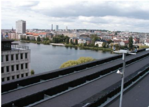
SID Anlægsstørrelse: 25 kWp Installationsår: 2002
