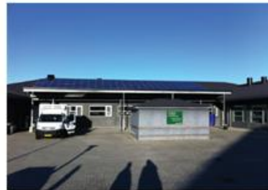
Hillerød Kommune, Produktionskokken Anlægsstørrelse: 30 kWp Installationsår: 2011
