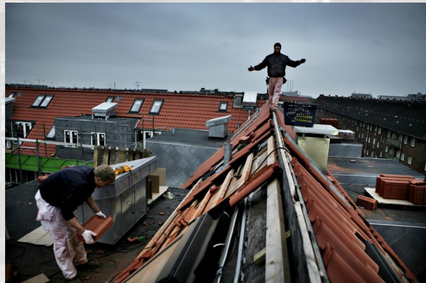
Bæredygtig byggeplads - minimering af affald, støj, støv og anden miljøpåvirkning, KS i prækvalifikation af entreprenører, KS i udførelse
