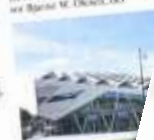
Med indstabile pe-nivauer og afbalanceret belastning bygningen – allerede reducerer energiforbruget.
