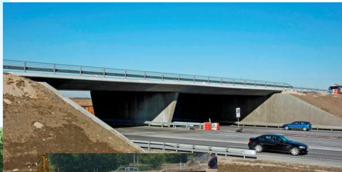
Bro over motorvej, Fløng
