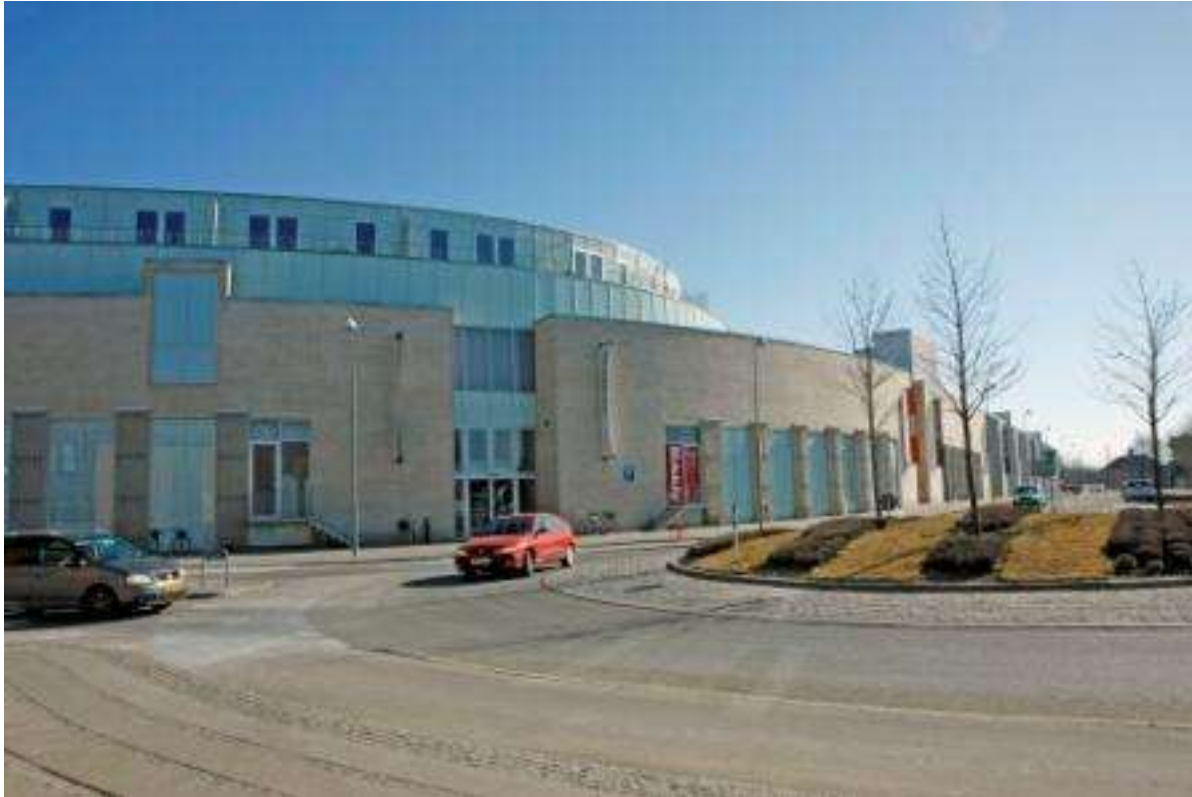
Sildebroen - indkøbscenter, Frederikssund
