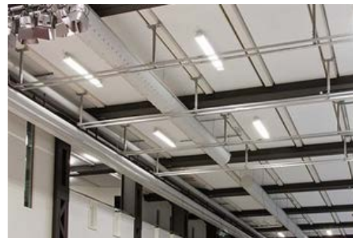
Showrooms / offentlige bygninger
